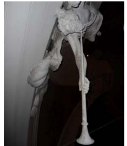
Stuckänglarna i Gustaf Vasa sett uppifrån i närbild. Dokumentationen visade hur änglarna fäster vid kupolen. En stuckteknik med gipsförsett tyg är upphängt i kupolen med olika metallanordningar. Foto: Martina Klukas.
